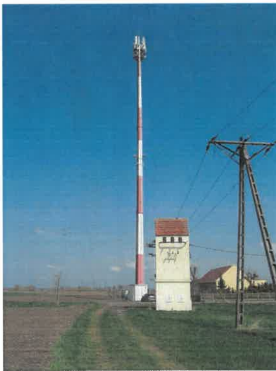
Zał. nr 1: Widok ogólny instalacji radiokomunikacyjnej.
