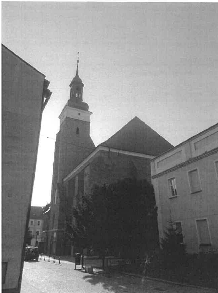
Zdjęcie 1 Badany obiekt
