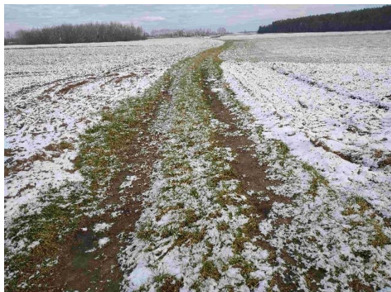
Fot. 24 Droga do przebudowy nr 1 – działka 288, odcinek gruntowy
