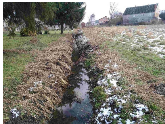
Fot. 5 Rów melioracyjny R - J
