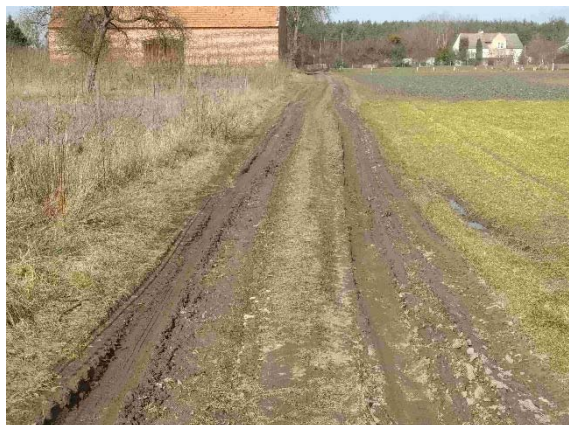
Fot. 27 Droga do przebudowy nr 3 – działka 291, odcinek gruntowy
