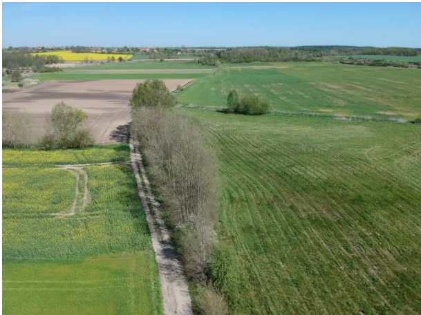
Fot. 2 Droga do przebudowy nr 2
