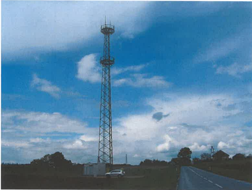
Fot. 1. Linia radiowa / Wińsko - widok wieży z anteną LR
